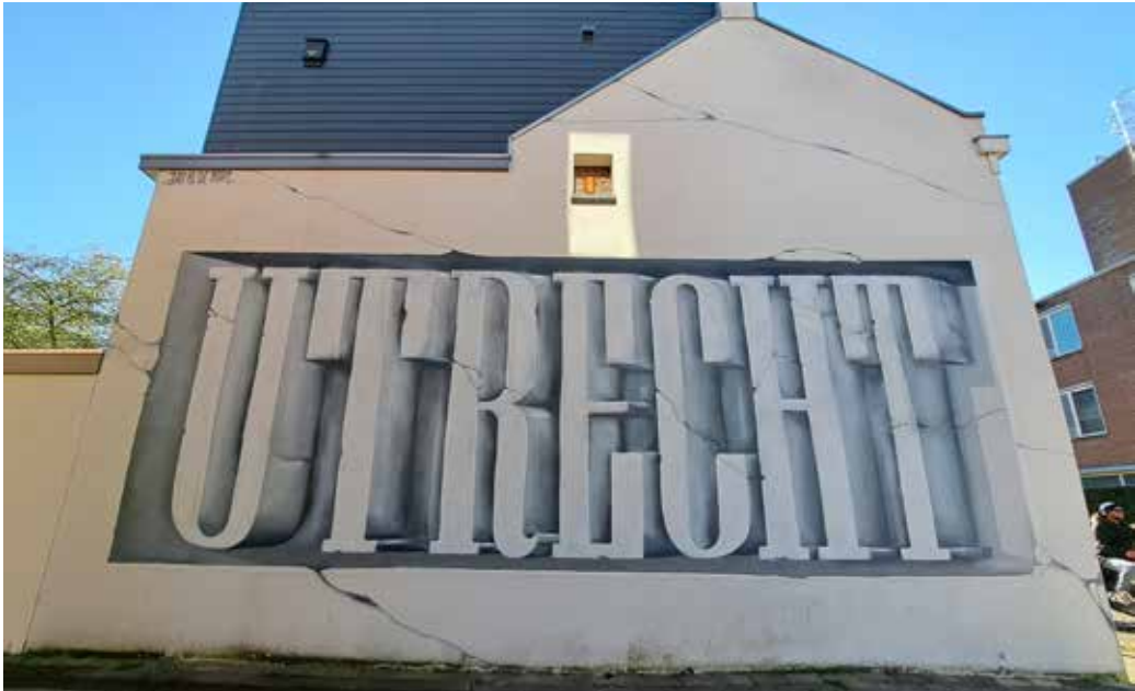
Muurschildering in combinatie met een dakopbouw
