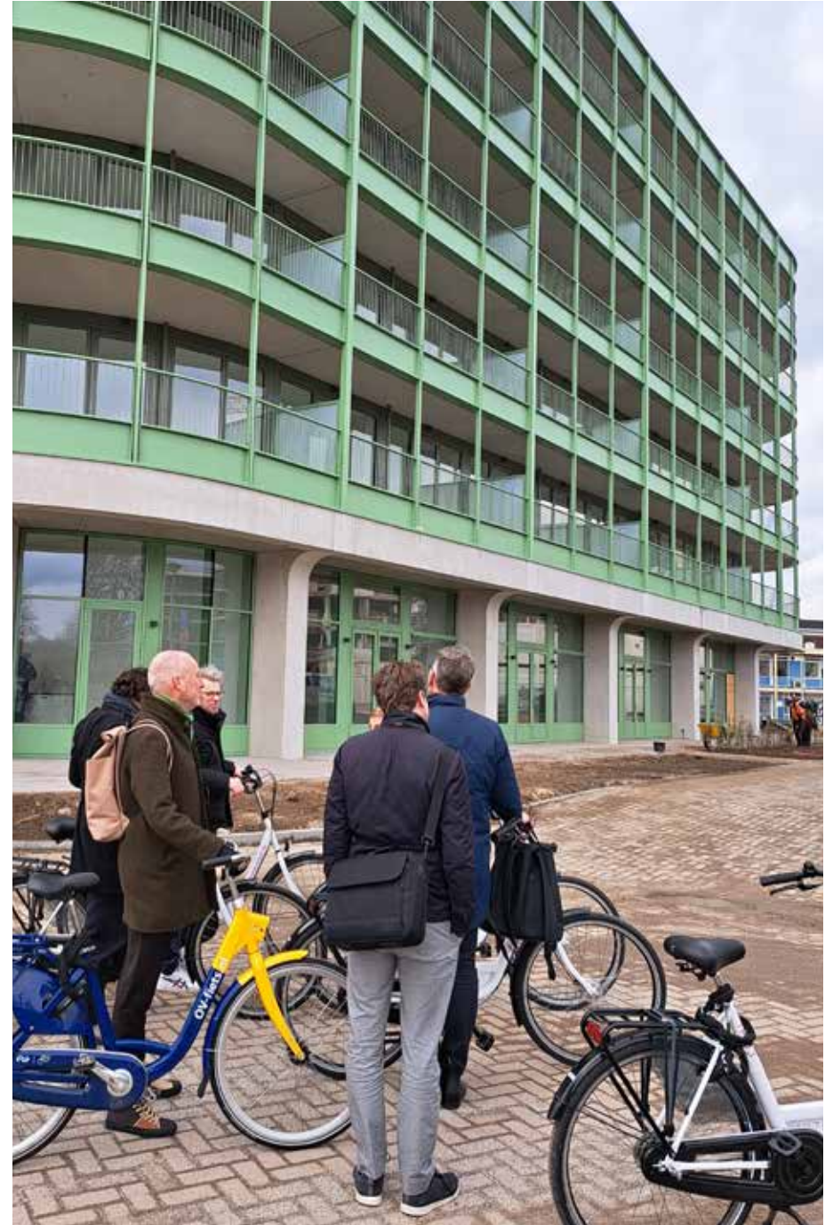
Gebouw Solo in de Cartesiusdriehoek
