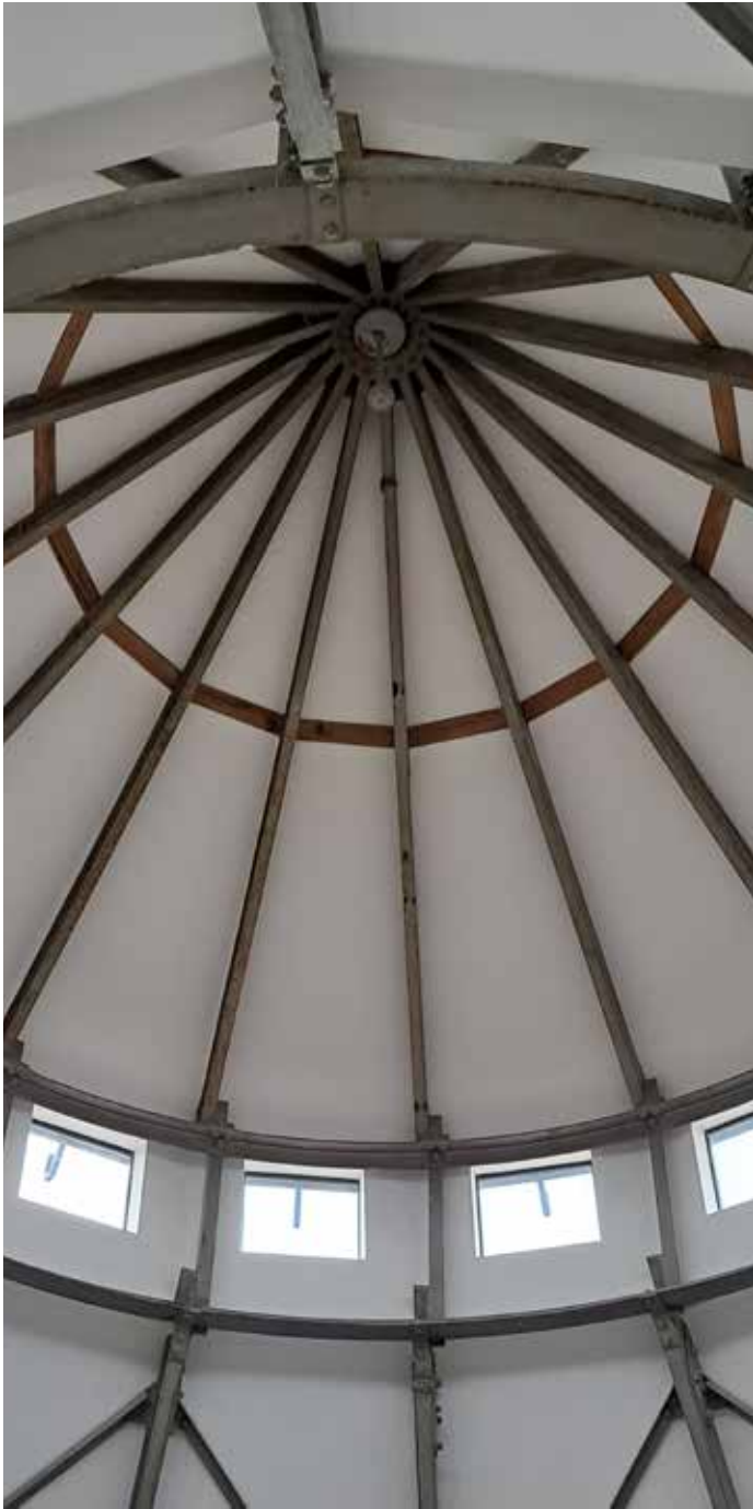
Dakconstructie koepel van de watertoren Amsterdamsestraatweg
