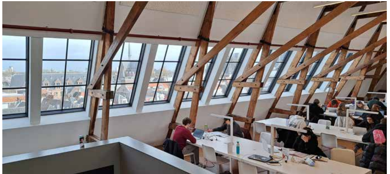
Kapverdieping met historische spanten van de Bibliotheek Neude
